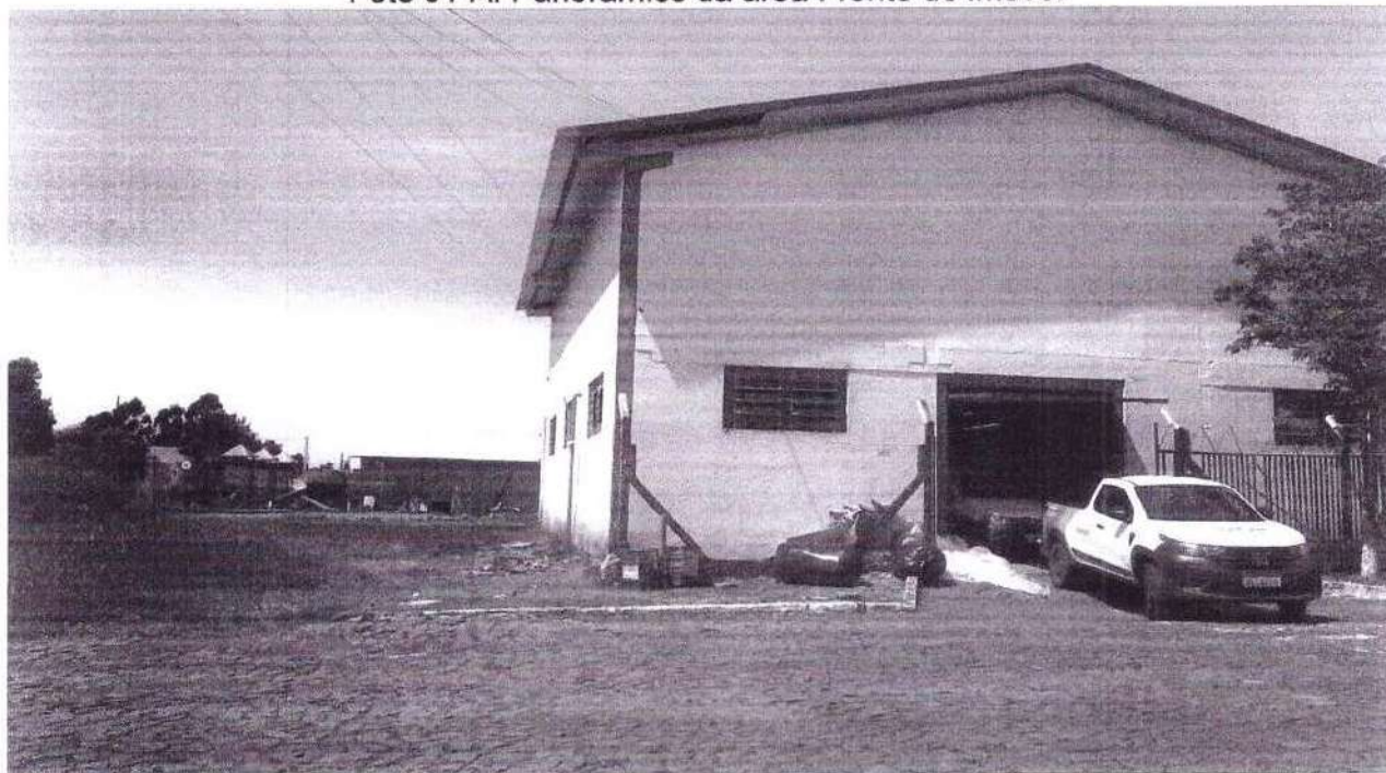
Foto 01-A: Panorâmico da área Frente do Imóvel
