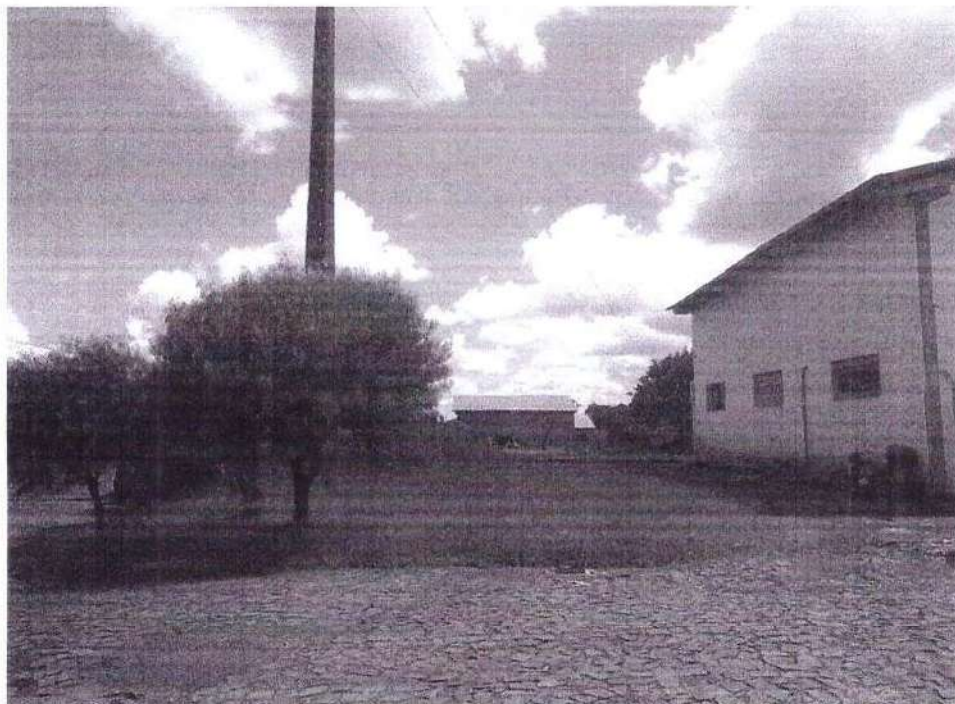
Foto 01-A: Panorâmico da área Frente do Imóvel
