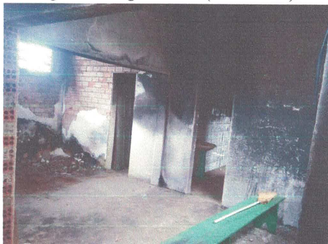
Figura 14 – Antigos banheiros (a ser demolido).
