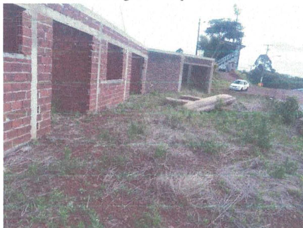
Figura 02 – Entrada principal do ginásio, onde será nivelado e compactado o subleito e executada laje de concreto e guarda corpo metálico.
