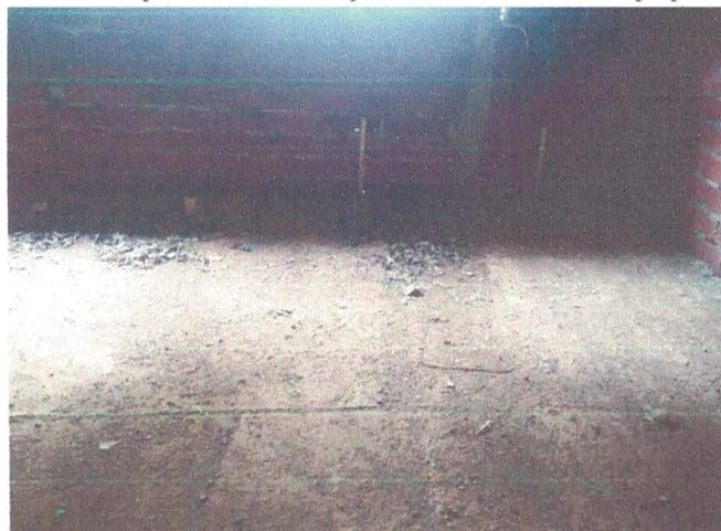
Figura 05 – Banheiro feminino, o qual receberá revestimento cerâmico no piso e paredes, bem como instalações hidráulicas e sanitárias juntamente com as louças. As tubulações sanitárias existentes serão removidas para serem readequadas de acordo com o projeto.
