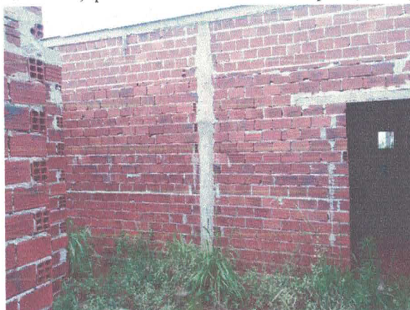
Figura 16 – Alvenaria externa, que receberá revestimento chapisco, emboço, reboco e pintura.
