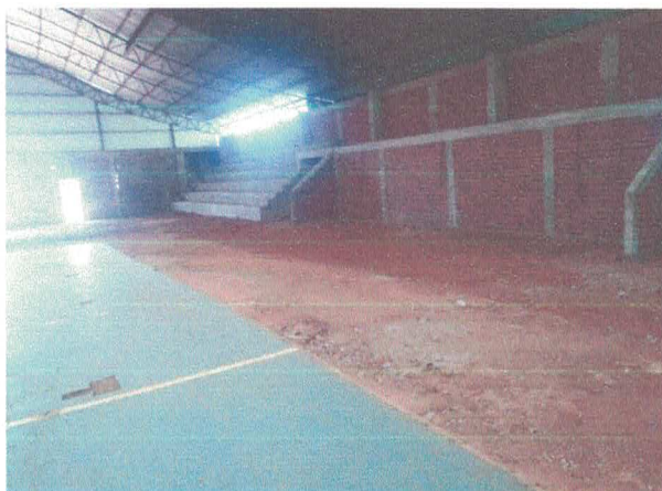
Figura 11 – Quadra de esportes, serão trocados os tacos de madeira existentes por novos, que deverão ser assentados com argamassa e receber impermeabilização a quente e pintura com tinta esmalte sintético brilhante.
