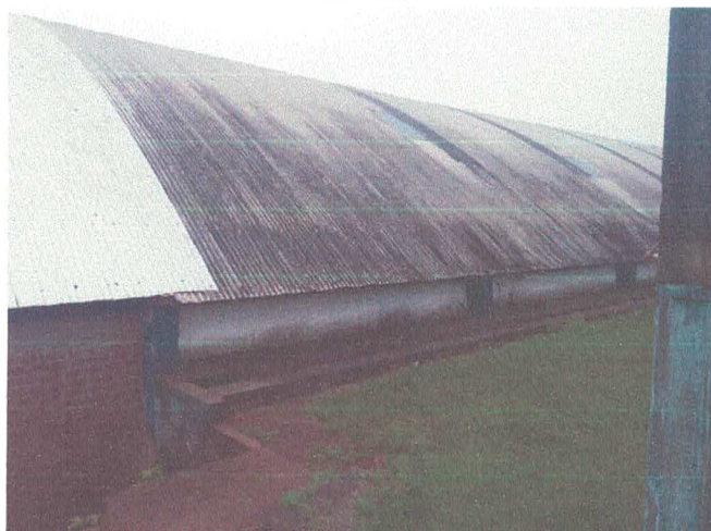
Figura 13 – Cobertura do ginásio, cuja parte antiga (parte mais escura) será trocada por nova cobertura de aluzinco.
