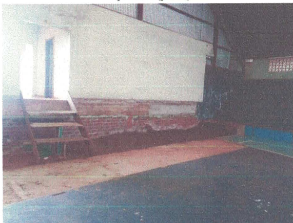
Figura 09 – Parede dos fundos a ser demolida, onde será executada novos pilares e vigas e receberá nova esquadria (porta).
